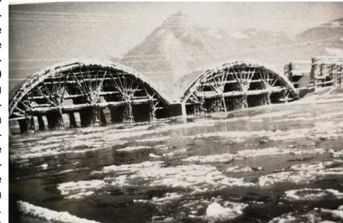
Fußgängerwege in Anpassung an die massive Brüstungsmauer ursprünglich mit großen Steinplatten gepflastert. Sie überspannt den Inn in drei Bögen mit einer lichten Weite von je 34,7 m. Die beiden Flusspfeiler sind oben 4 m und im Fundament 8,5 m breit, sie reichen bis 3,6 m unter die Flusssohle. Die Brückenhöhe beträgt 12 m über Niederrwasser. Die Brücke übersetzt den
